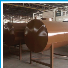
Depósitos de combustible
